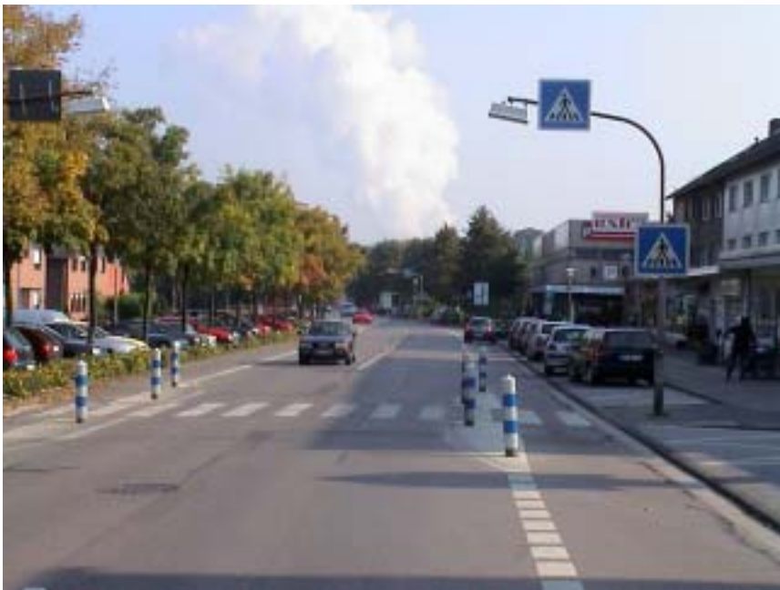
Bedburg-Kaster, K 36, Fußgänger-LSA durch FGÜ ersetzt
