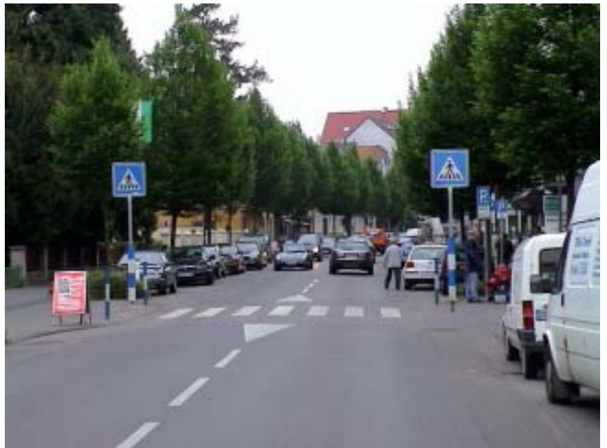
Kerpen-Horrem, L 163, neuer FGÜ an bestehender Einengung
