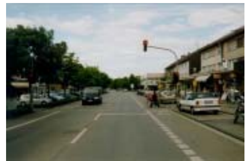
Bedburg-Kaster, K 36, vorher
