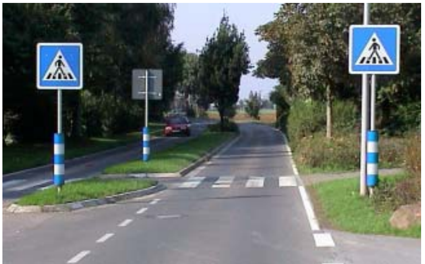
Standort 03, Bergheim-Ahe, K 19, neuer FGÜ an bestehendem Fahrbahnteiler
