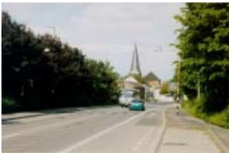
Bedburg-Kaster, K 36, vorher
