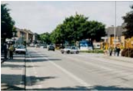
Bedburg-Kaster, K 36, vorher
