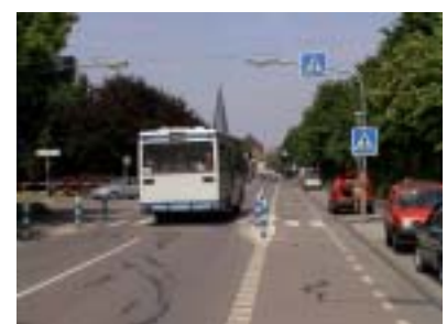
Wartefläche zwischen Radfahrstreifen und Fahrbahn
